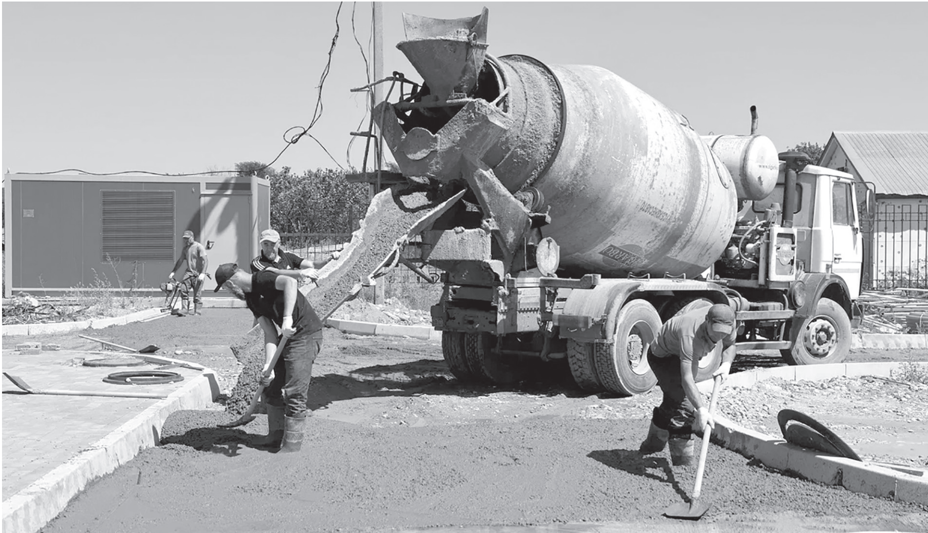
Интенсивно ведутся работы и на школьном дворе
